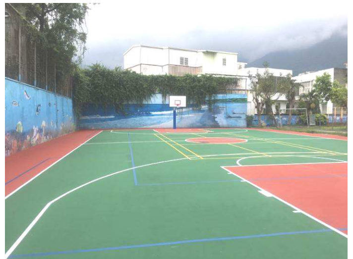
綜合球場施工後
