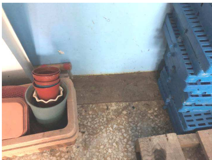
幼稚園旁樓梯漏水修繕
