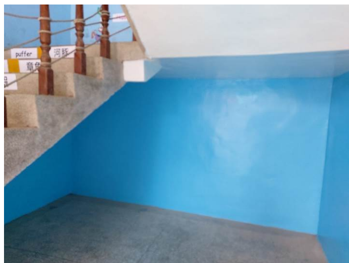
防水設施及牆面重新粉刷
