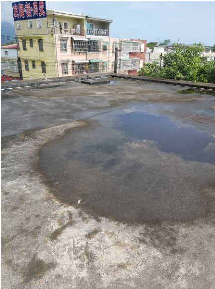
風雨教室樓頂防水施工前
