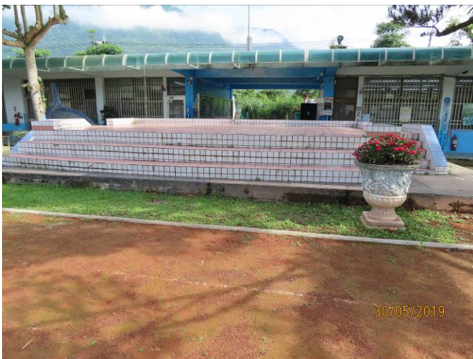
司令台施工前
