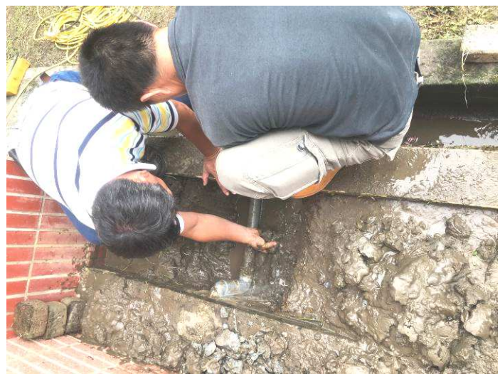
風雨教室外水管爆裂修繕
