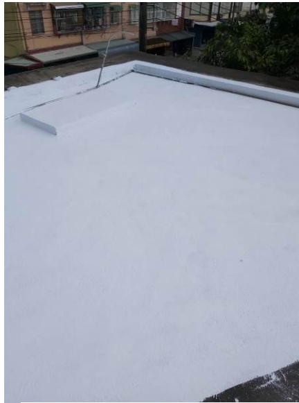
風雨教室樓頂防水施工後
