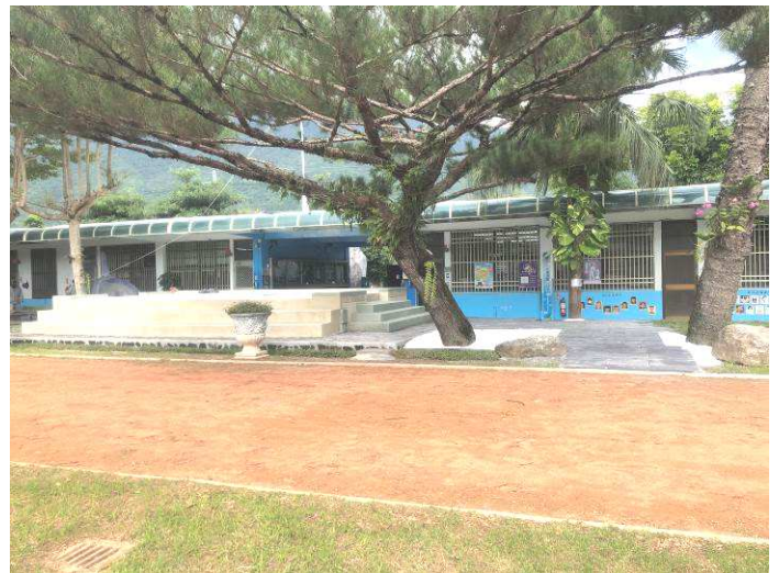
司令台施工後
