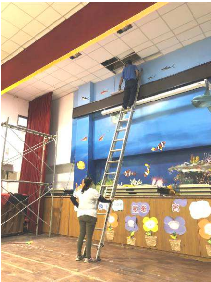
風雨教室天花板修繕
